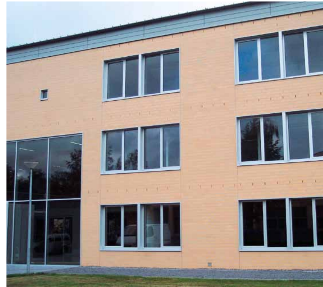
Aluminium-Fensterelemente mit außenliegenden Fensterbänken, eingesetzt in die Fensterzargen einer Steinfassade
