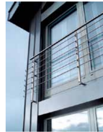
Raumhohe Aluminium-Fensteranlage mit außenliegender Absturzsicherung eines Wohnhauses
