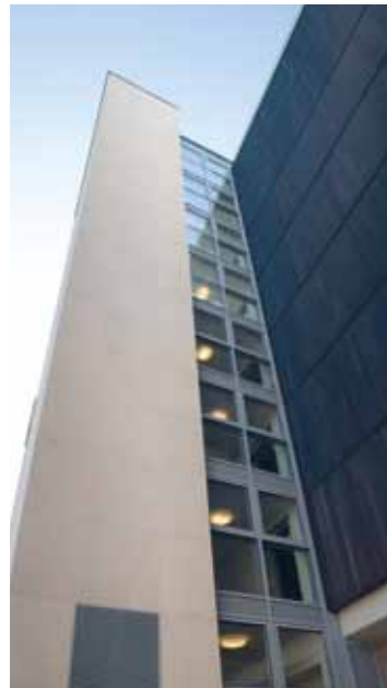
Pfosten-Riegel-Konstruktionen mit integrierten Aluminium-Fenstern und Brüstungsverkleidungen
