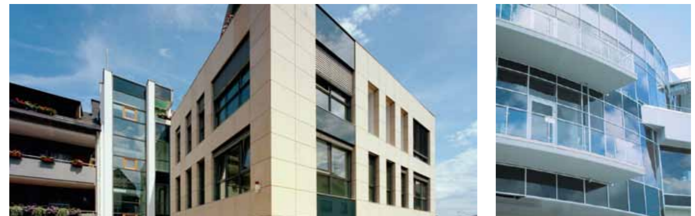
Riegel-Riegel-Konstruktion eines Treppenhauses und Aluminium-Fenster mit Sonnenschutz-Vertikaljalousien in einer Naturstein-Fassade
