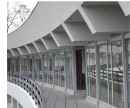
Raumhohe Glas-Fassadenelemente, mit polygonaler Anordnung in einem Rundbau
