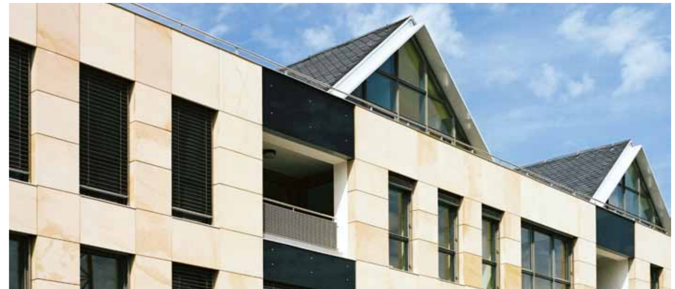
Aluminium-Fensterelemente in einer Naturstein-Fassade
