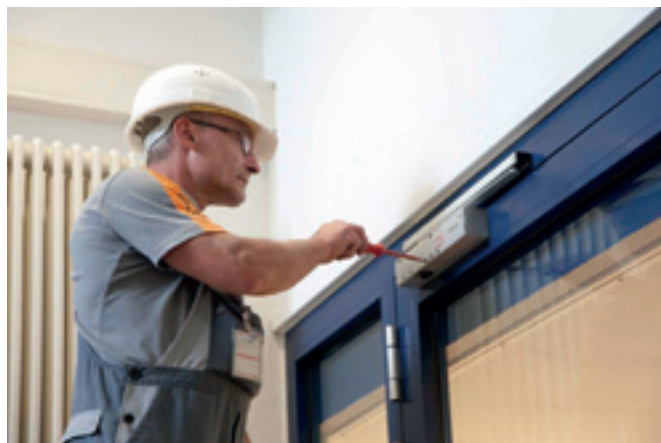
Justierung der SchließEinstellung eines Obentürschließers
