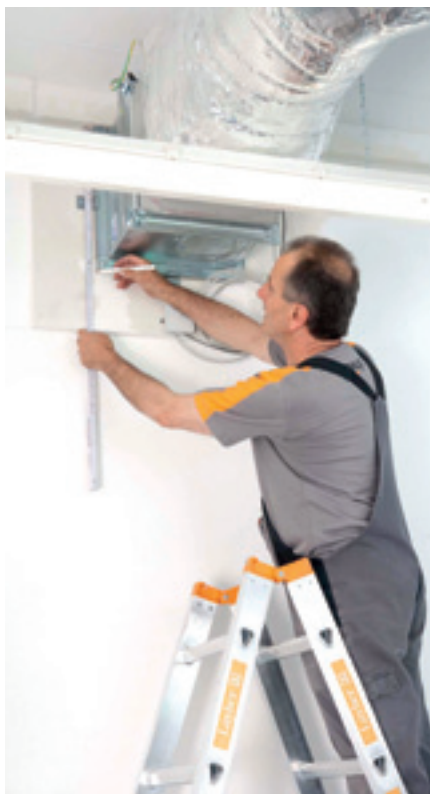
Nachrüstung einer Brandschutzklappe K 90 in einer Leichtbauwand
