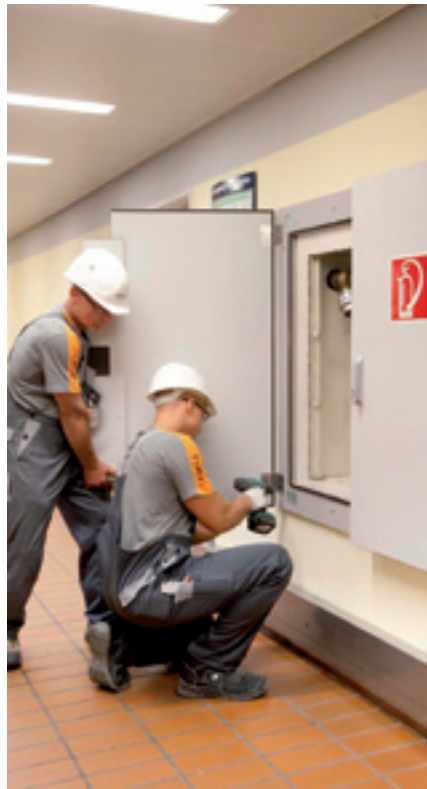
Bekleidung eines Feuerlöschkastens mit einer F 30 Klappe
