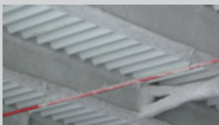
Freiliegende Konstruktionsteile werden von der Spritzmasse ummantelt
