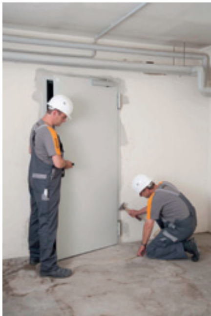
Montage einer Feuerschutztür
