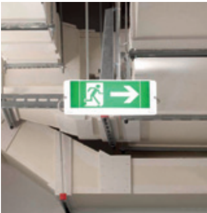
L 90 Luftkanalbekleidung mit Brandschutzplatten
