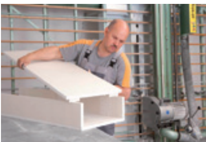
Vorfertigung eines Brandschutzkabelkanals
