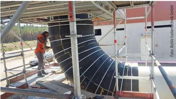
Abb. 4: Da bei der Erdgasverdichtung Hitze entsteht, war unter Berührungs- und Arbeitsschutz Gesichtspunkten eine Rohrinsolierung in 100 mm Dicke vorgesehen.
