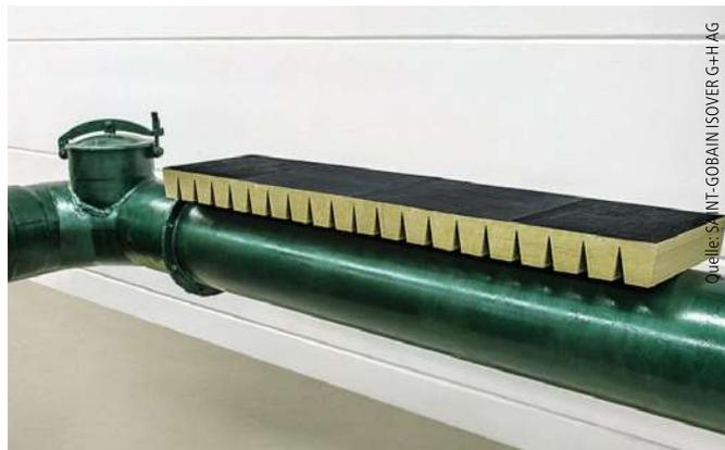
Abb. 6 und 7: Zur Montage wurden die Platten auf dem Rohr bzw. dem Untergrund abgelegt und der Länge nach ausgeklappt.
