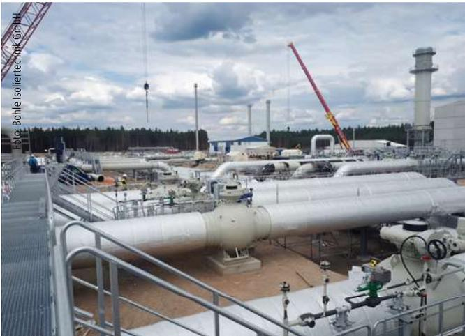
Abb. 2: Zum zusätzlichen Schutz der Dämmung vor Tauwasser wurde abschließend eine selbstklebende Alubutylfolie aufgebracht.
