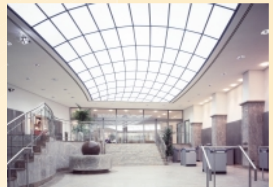
FORUM-Lichtdecke gewölbt und gerundet, mit Kopfstücken als Spiegel ausgebildet, in der Sparkasse Bielefeld
