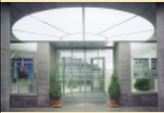
FORUM-Lichtdecke gerundet, im überdachten Außenbereich der Volksbank in Eschweiler
