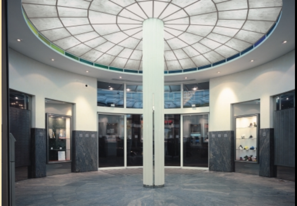
FORUM-Lichtdecke gewölbt und gerundet, mit Kopfstücken als Spiegel ausgebildet, in der Sparkasse Bielefeld
