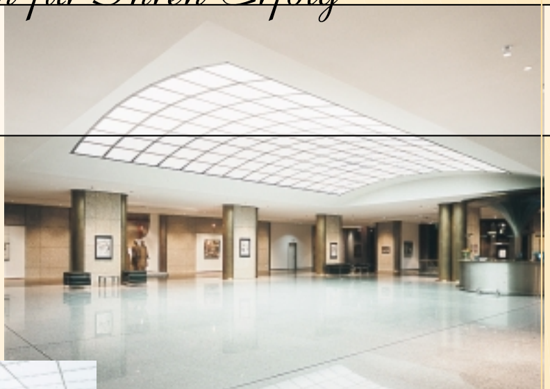
FORUM-Lichtdecke als Tonnengewölbe, mit integrierter Luftführung, im Internationalen Handelszentrum, Bremen
