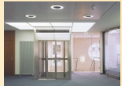
FORUM-Lichtdecke als Einlegemontage in der Kreissparkasse Dorsten
