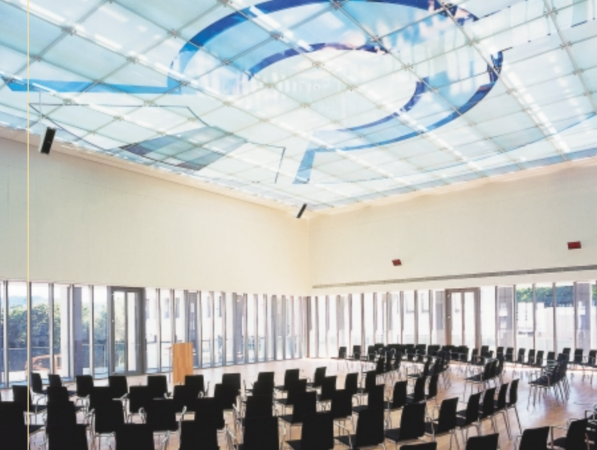
FORUM-Lichtdecke mit Punkthalterung (Auflagesystem) im Vortragssaal der Europäischen Rechtsakademie in Trier. Künstlerische Glasgestaltung Karl Heinz Traut über DERIX, Taunusstein
