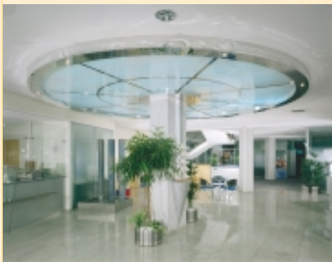
FORUM-Lichtdecke rund gebogen, mit verchromter Randausbildung, im SB-Bereich der Volksbank in Diez
