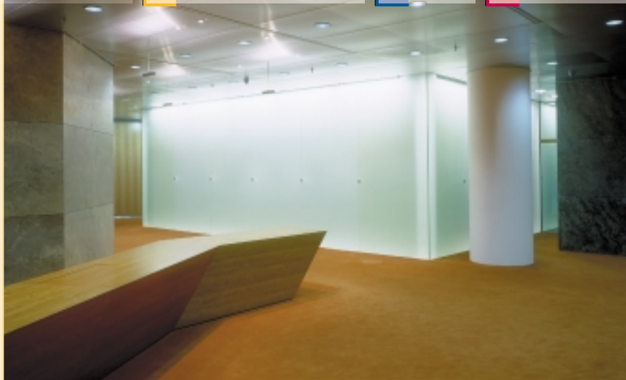
FORUM-Lichtwand in der Europäischen Zentralbank (EZB) Frankfurt Konstruktion aus Klemmprofilen und hängenden Glasscheiben
