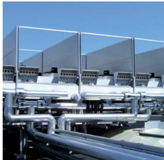
Schallschirm-Konstruktionen auf Dächern von Industriehallen
