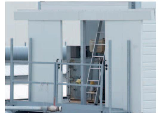
Schirmwand mit integrierter Schiebetür
