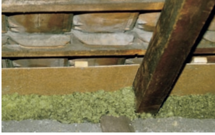
Drempeldämmung mit Hinterlüftung
