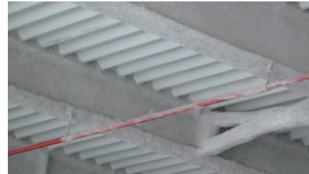
Freiliegende Konstruktionsteile werden von der Spritzmasse ummantelt
