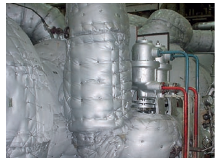
Komplette Turbinenisolierung mit Isoflex-Dämmkissen
