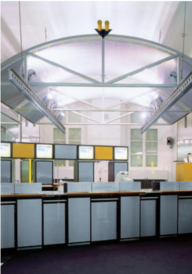
Gewölbte Deckensegel aus Metall mit integrierter Beleuchtung
