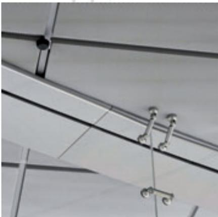
Detail einer Streckmetall-Kassettendecke mit untergesetzter Glaswand
