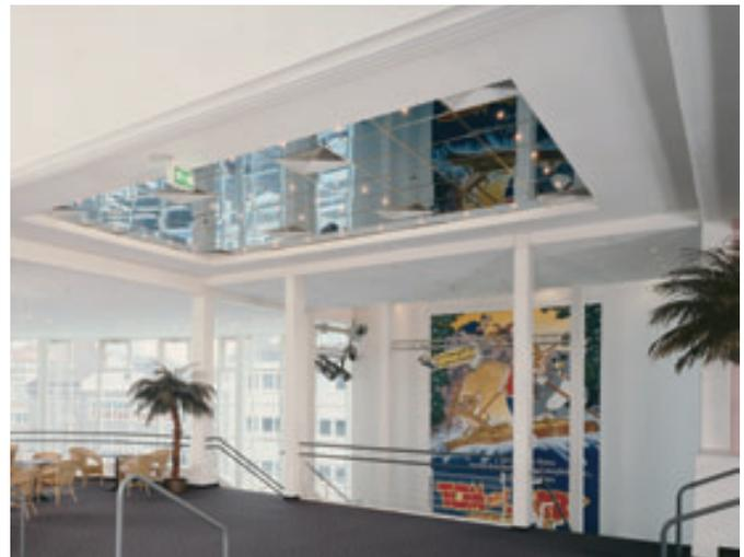
Gipskarton-Deckenverkleidung mit eingelassenem Spiegelraster-Deckenfeld in einem Cinema-Center
