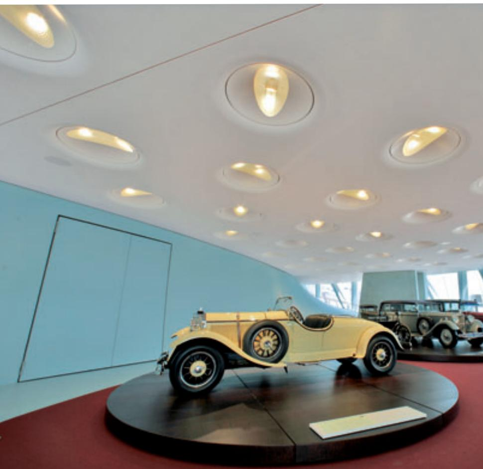
Kühldeckenverkleidung mit Lochgipsplatten und integrierten Sonderleuchten in einem Museum
