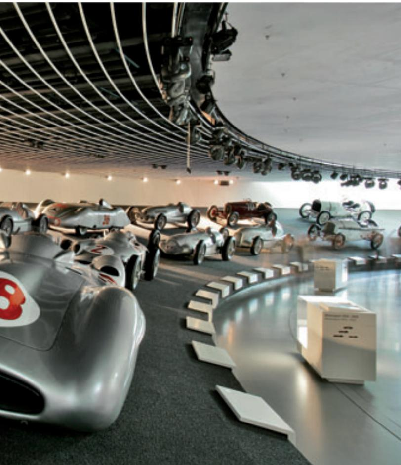
3D-geformte Aluminium-Rohr lamellendecke in einem Museum
