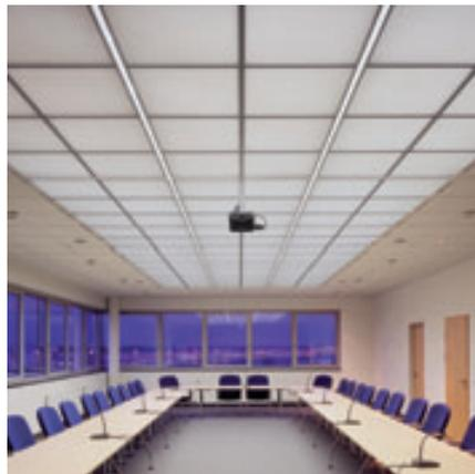
Kombinierte Kühl-, Licht- und Lüftungsdecke im Besprechungsraum eines Flughafens
