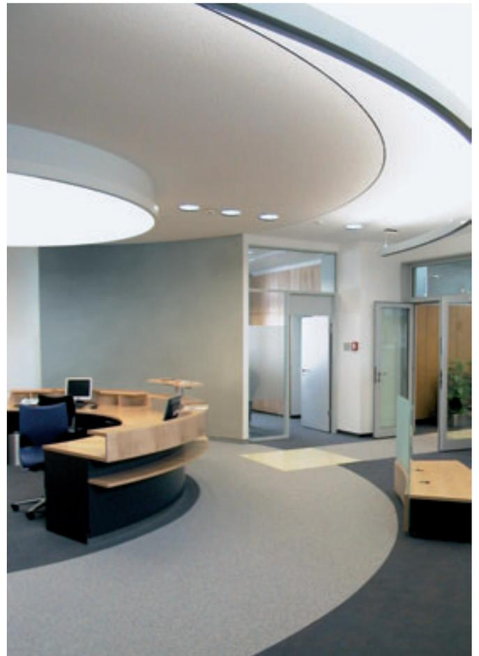
Akustikputz-Deckenverkleidung mit untergesetztem runden Lichtdeckensegel
