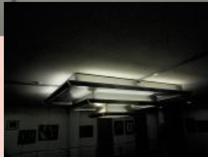
FORUM-Sonderleuchte aus Edelstahl und Glas mit motorischer Absenkung in der Kundenhalle der Sparkasse Neustadt an der Aisch
