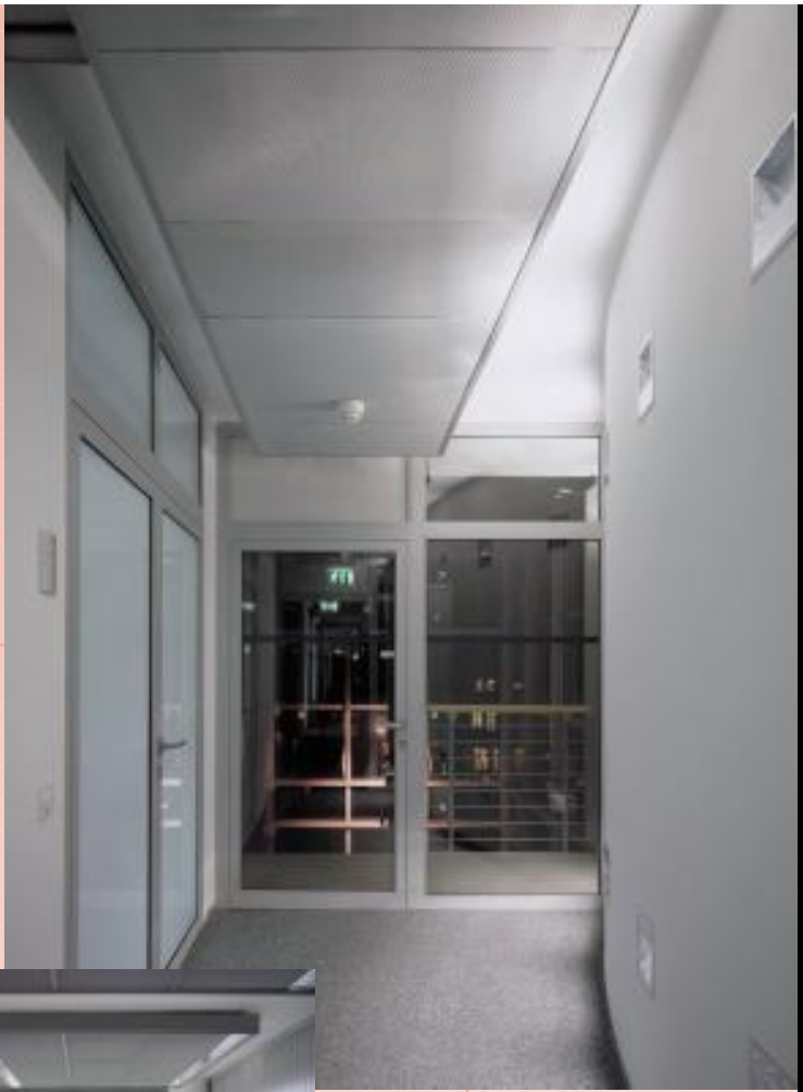
FORUM-Deckensegel im Flurbereich zur Abdeckung der Kühlwasserleitungen.
