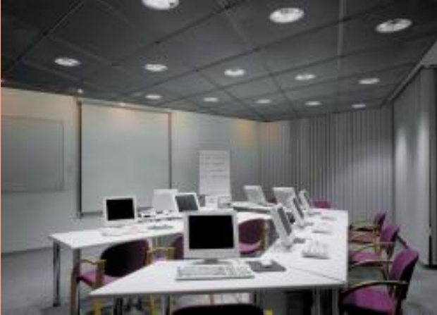
FORUM-Kühlsegel mit Streckmetallkassetten und eingebauten Downlights in einem Schulungsraum des Deutschen Herolds in Bonn
