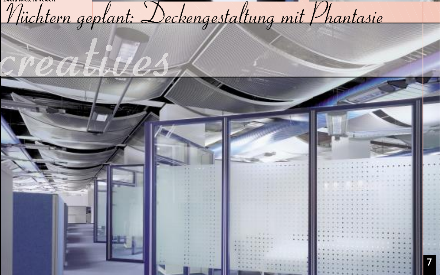
FORUM-Deckensegel in gebogener Ausführung mit einer Bekleidung aus Streckmetall als untere Abdeckung einer kombinierten Kühl-/Akustikdecke in Großraumbüros der Firma Ewald Witte in Velbert
