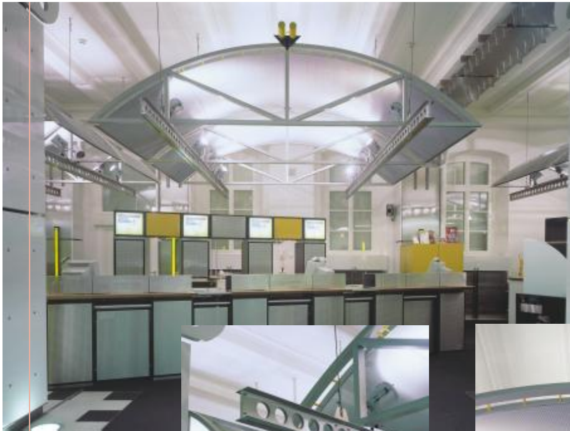
FORUM-Deckensegel in einem Kunden- zentrum der Deutschen Post in Bonn. Gebogene Aluminiumkonstruktion mit eingespannten Streckmetallflächen
