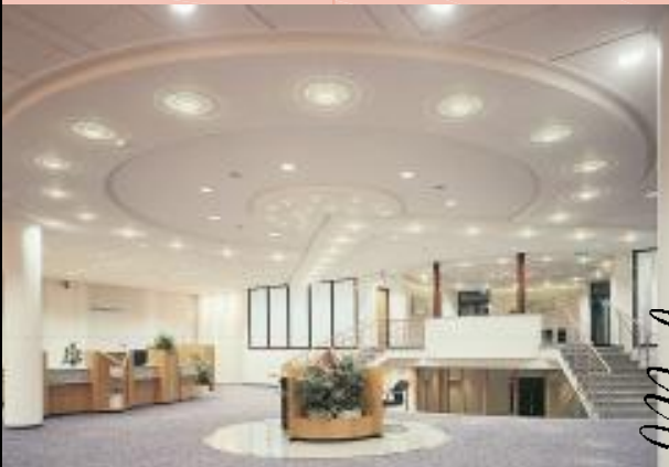
Gestaltete FORUM-Decke mit Kühl- funktion im Eingangsbereich einer Sparkasse in Parchim
