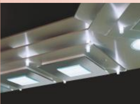
Mehrstufiges Edelstahlsegel mit Sonderleuchten
