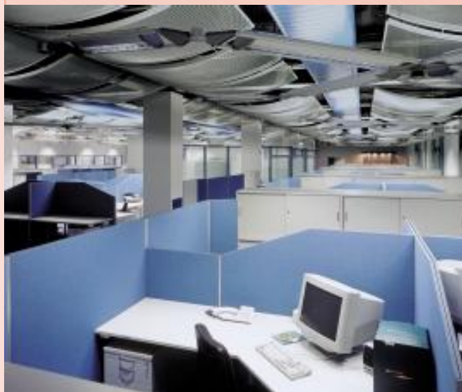
FORUM-Deckensegel in gebogener Ausführung mit einer Bekleidung aus Streckmetall als untere Abdeckung einer kombinierten Kühl-/Akustikdecke in Großraumbüros der Firma Ewald Witte in Velbert
