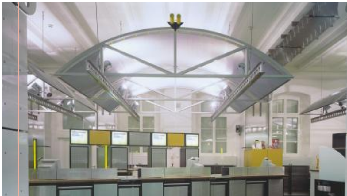
FORUM-Deckensegel in einem Kundencentrum der Deutschen Post in Bonn. Gebogene Aluminiumkonstruktion mit eingespannten Streckmetallflächen
