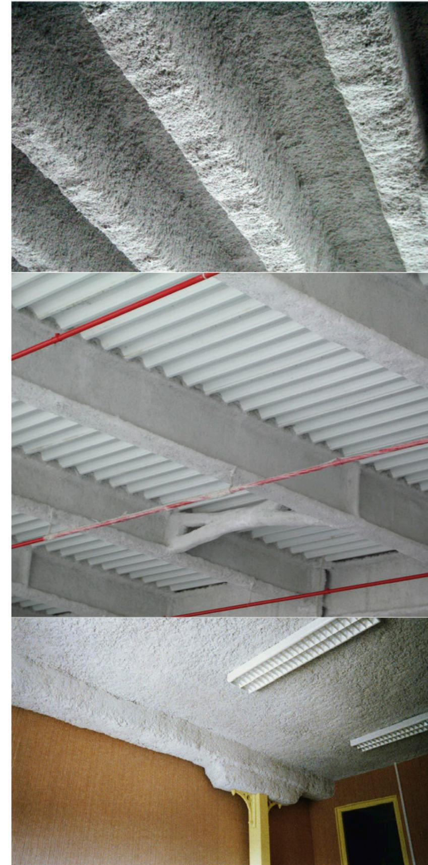
Spritzdämmsysteme sind prädestiniert für die Dämmung von Betonbauteilen und Stahltragwerken wie z. B. Kellerdecken, Stahlträger und Lüftungskanäle. Die Spritzdämmsysteme – richtig verarbeitet – haften auf nahezu jedem Untergrund.
