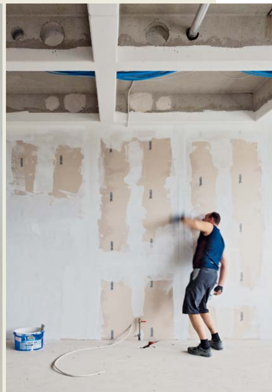
Einfach glatt. In allen Fluren und Klassenräumen kamen großformatige Hydropanel-Platten mit 2 abgeschägten Kanten zum Einsatz. Die Stoßübergänge wurden mit dem speziellen Hydropanel-Spachtel abgezogen.
