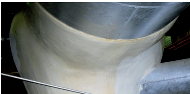
Detailansicht einer Spritzisolierung eines Schnellverschlussventils
