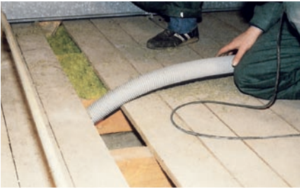
Einfach zu realisieren: Eine Holzbalkendecke erhält eine Einblasdämmung
