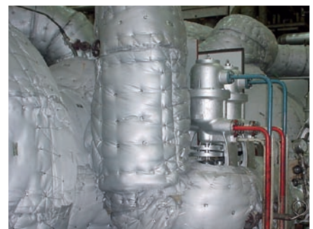
Komplette Turbinenisolierung mit Isoflex-Dämmkissen
