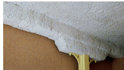
Spritzdämmsysteme haften an allen festen Oberflächen, in diesem Fall Holzbalkendecke und Holzträger
