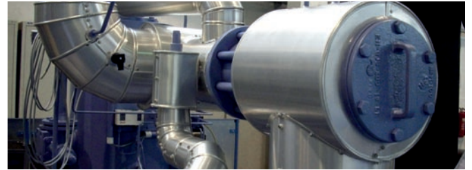
Mit PUR-Ortschaum und Alublech gedämmter Kühlwassersatz
