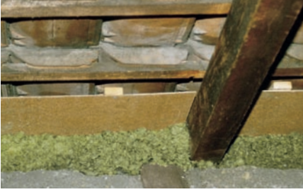
Drempeldämmung mit Hinterlüftung
