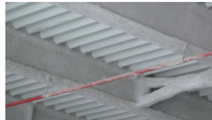
Freiliegende Konstruktionsteile werden von der Spritzmasse ummantelt
