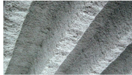
Ob Träger oder Beton – das Spritzsystem folgt gleichmäßig dem Profil des zu dämmenden Objekts
