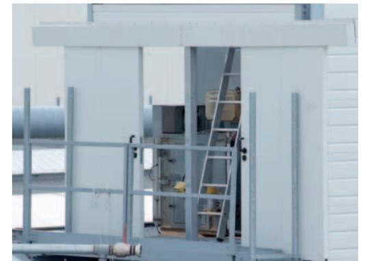
Schirmwand mit integrierter Schiebetür
