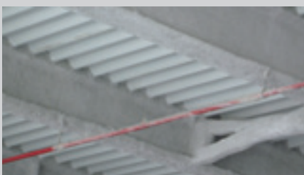
Freiliegende Konstruktionsteile werden von der Spritzmasse ummantelt
