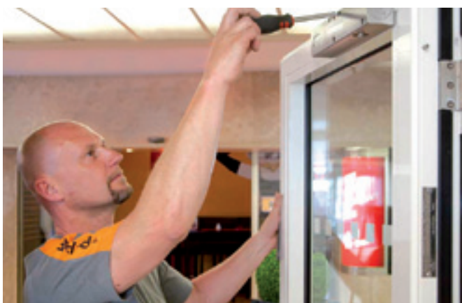
Wartung einer Feststellanlage
