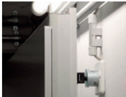
Haftmagnet einer Feststellanlage
