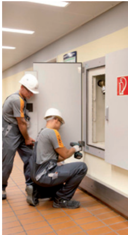
Bekleidung eines Feuerlöschkastens mit einer F 30 Klappe
