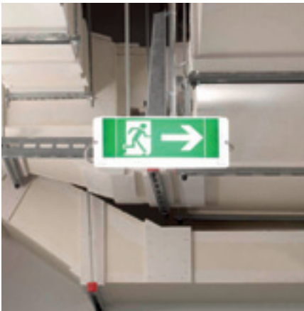
L 90 Luftkanalbekleidung mit Brandschutzplatten
