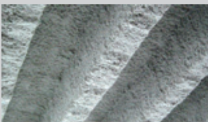
Ob Träger oder Beton – das Spritzsystem folgt gleichmäßig dem Profil des zu dämmenden Objekts
