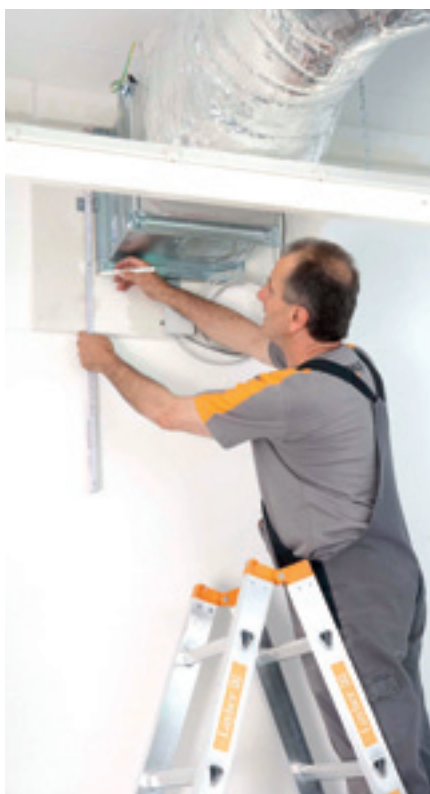
Nachrüstung einer Brandschutzklappe K 90 in einer Leichtbauwand
