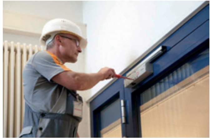
Justierung der SchließEinstellung eines Obentürschließers
