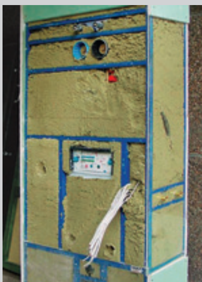
Eindrucksvolle Demonstration für die lückenlose Ausfüllung mit Einblasdämmung. Die Gipskartonplatten einer Vorwandmontage wurden hierfür entfernt.
