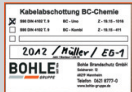
Bauaufsichtliche Kennzeichnung für eine Kabelabschottung
