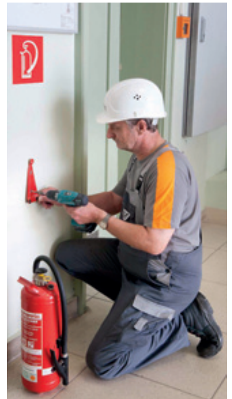
Installation eines Feuerlöschers
