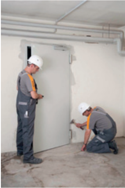
Montage einer Feuerschutztür
