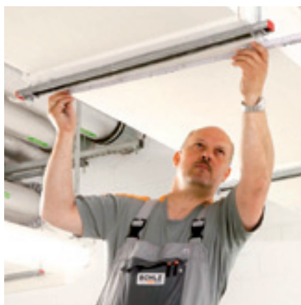
I 30 Elektrokabelkanalbekleidung
