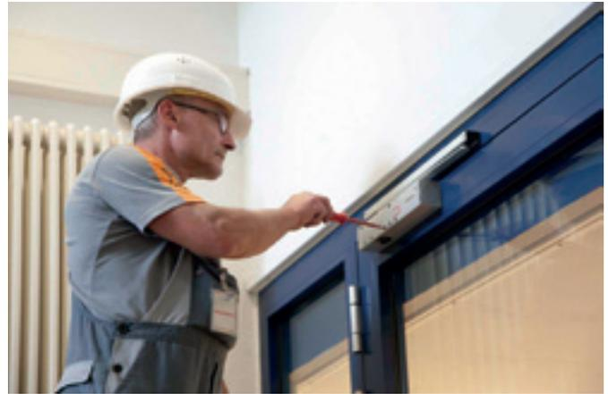
Justierung der SchließEinstellung eines Obentürschließers
