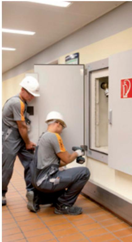
Bekleidung eines Feuerlöschkastens mit einer F 30 Klappe
