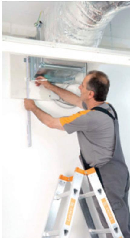
Nachrüstung einer Brandschutzklappe K 90 in einer Leichtbauwand
