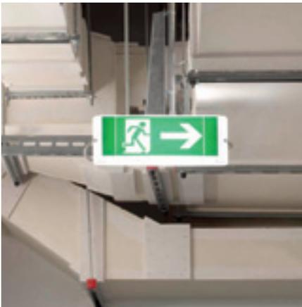
L 90 Luftkanalbekleidung mit Brandschutzplatten
