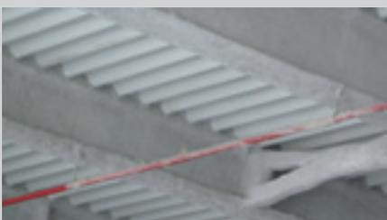
Freiliegende Konstruktionsteile werden von der Spritzmasse ummantelt
