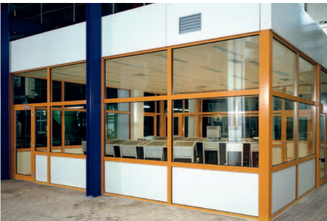
Nastawnia z klimatyzacją
