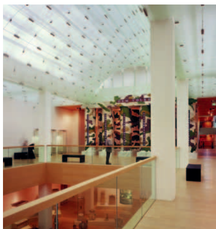
Sklepienie sufitu z oświetleniem i wyjmowanymi płytami w muzeum
