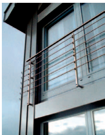
Aluminiowe zestawy okienne na wysokość pomieszczenia z barierką zewnętrzną na bloku mieszkalnym
