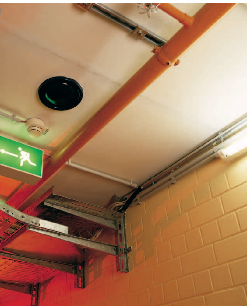
Sufit przeciwpożarowy F90 z zakresu techniki budynków
