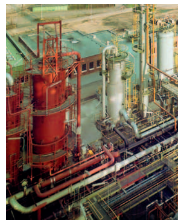
Ochrona antykorozyjna na kolumnach i rurociągach
