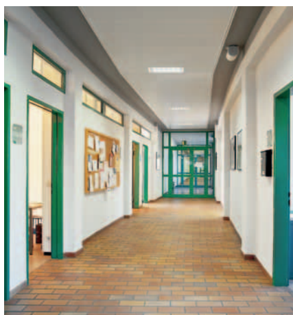
Okładziny sufitów w korytarzu F30, rozkładane
