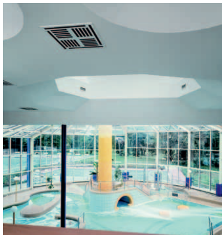
Oktadzina sufitu z tynku akustycznego na basenie
