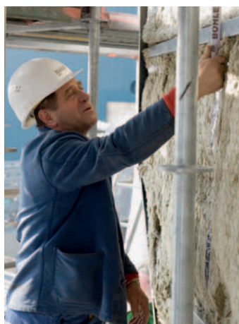
Prace izolacyjne na elektrofiltrze
