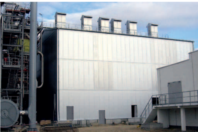
Ochrona akustyczna konstrukcji hali
