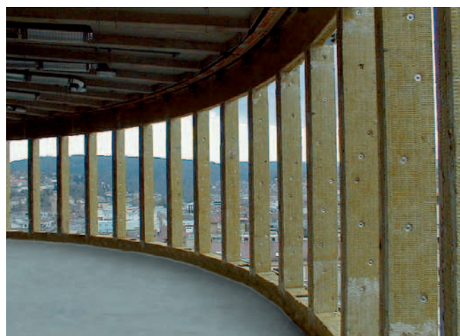
Okładzina przeciwpożarowa na wspornikach stalowych
