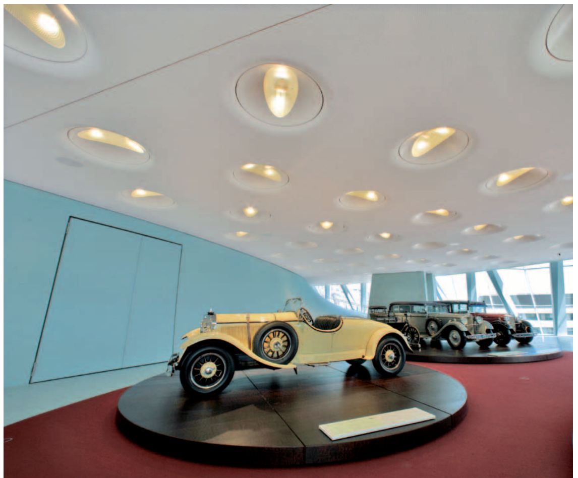
Sufity gipsowe z wbudowanym oświetleniem specjalnym
