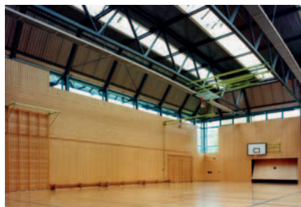
Oktadzina ściany drewnianej odporna na uderzenia w hali sportowej
