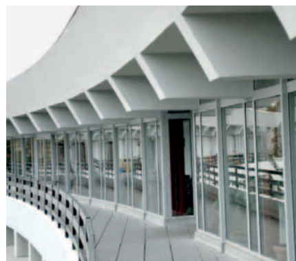
Szklane elementy fasady na wysokość pomieszczenia, o rozmieszczeniu wielokrawędziowym w budynku okrągłym
