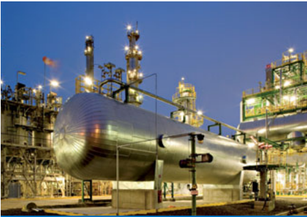
Kälteisolierung in einer Raffinerie
