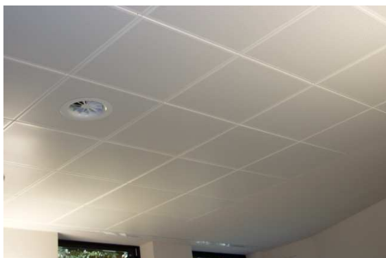
[Abb.8] Metall-Kühldecke als Klemmsystem
