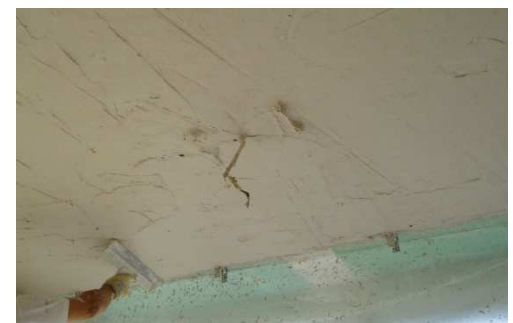
[Abb.14] Verputzen und Glätten des Putzes
