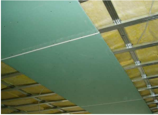
[Abb.9] Beplankung mit imprägnierter GK-Platten
