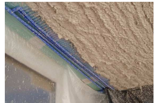
[Abb.13] Putzauftrag
