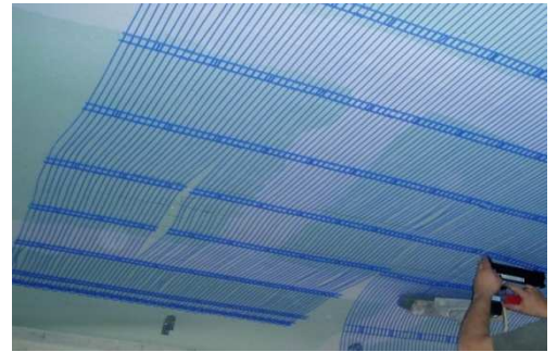
[Abb.12] Installation der PP-Matten auf die GK-Decke
