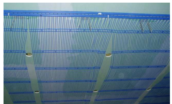
[Abb.20] Öffnungen für Einbauten in abgehängter GK-Decke
