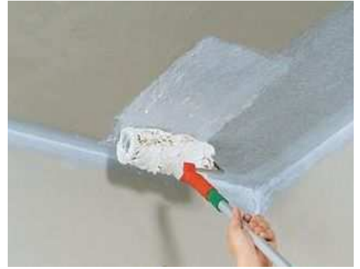
[Abb.11] Grundierung vor dem Putzen
