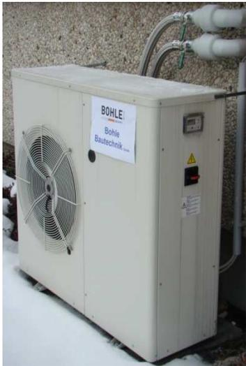
[Abb.5] Kältemaschine für die Kaltwassererzeugung
