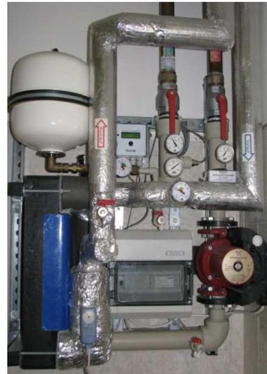
[Abb.6] Übergabestation für die Systemtrennung
