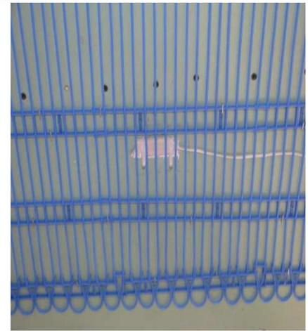
[Abb.3] Ein Feuchtesensor verhindert Kondensatbildung auf gekühlten Flächen
