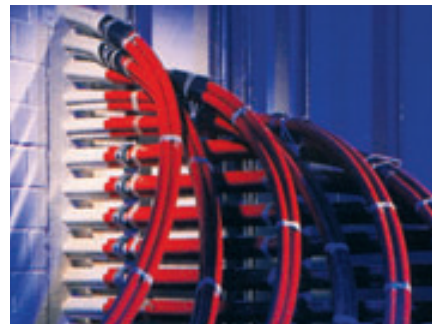
Kabelschott
