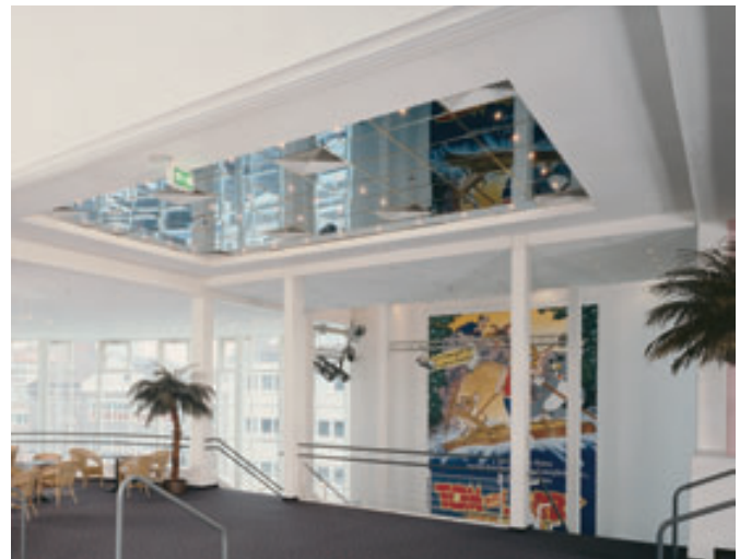
Gipskarton-Deckenverkleidung mit eingelassenem Spiegelraster-Deckenfeld in einem Cinema-Center
