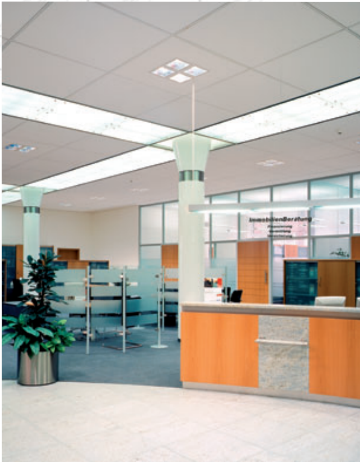
Akustikdecke mit FORUM®-Profilen und eingearbeiteten Glaslichtdecken, jede einzelne Scheibe ist abklappbar
