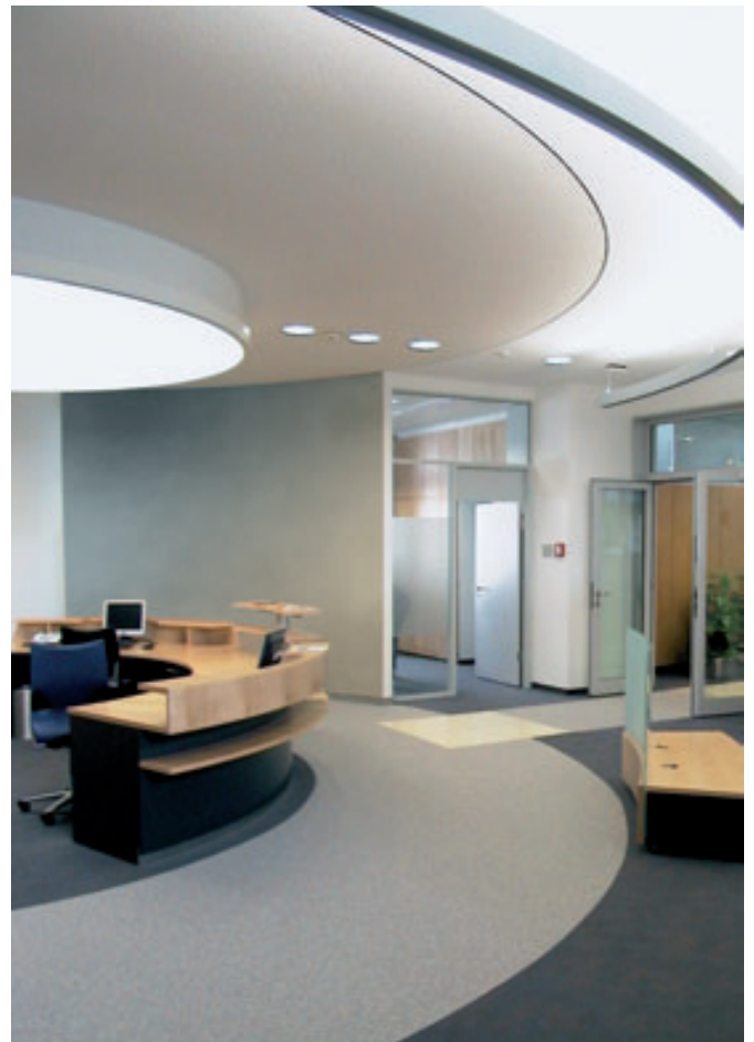
Akustikputz-Deckenverkleidung mit untergesetztem runden Lichtdeckensegel
