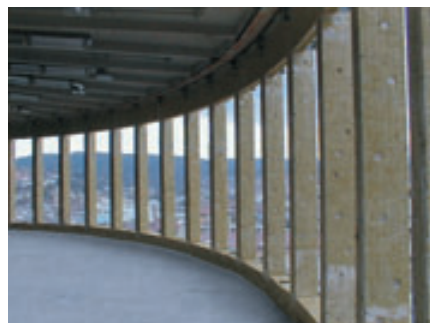
Feuerschutzverkleidungen an tragenden Stützen in einem Bürohaus
