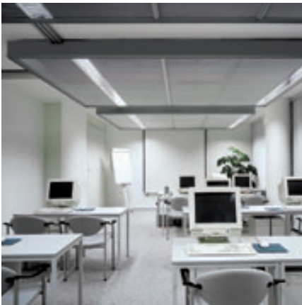
Kühldecken-Segel mit aufliegenden Kühlmännern und eingebauten Leuchten
