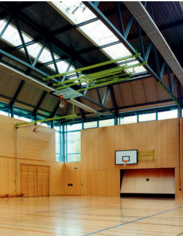
„Ballwurfsichere“ Wand- und Deckenverkleidungen aus Holz
