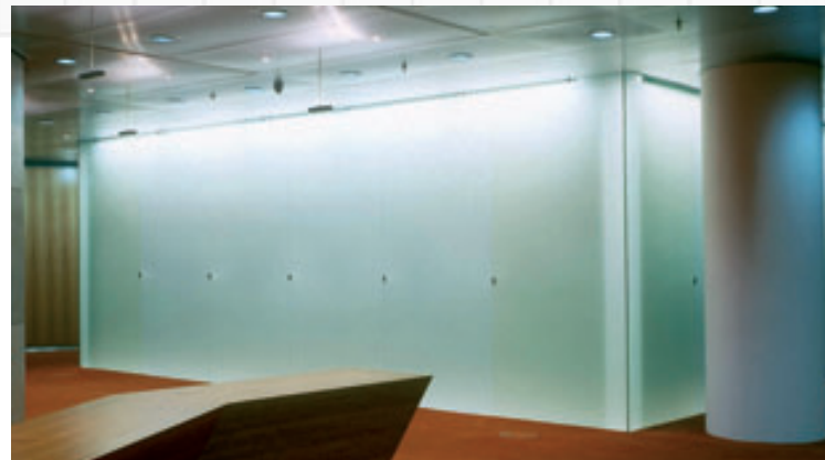
Freistehende Lichtwand in einer Bank
