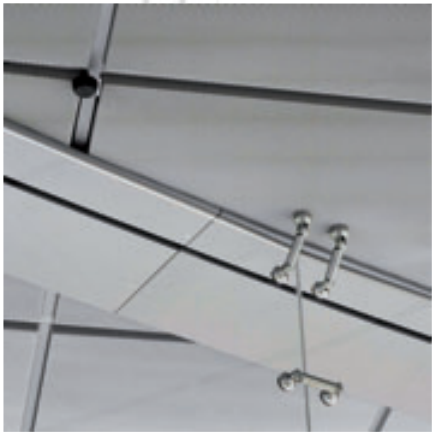
Detail einer Streckmetall-Kassettendecke mit untergesetzter Glaswand
