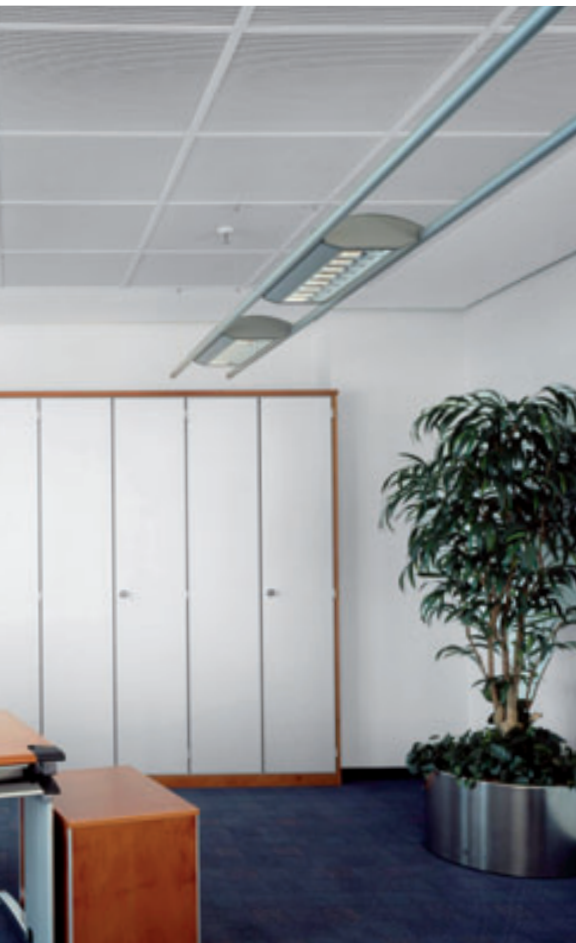
Kombinierte Kühl-, Licht- und Lüftungsdecke im Besprechungsraum eines Flughafens
