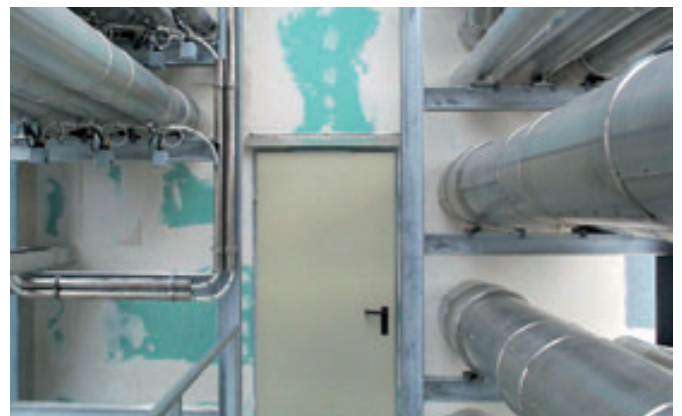
Brandschutzwand mit Rohrschotts
