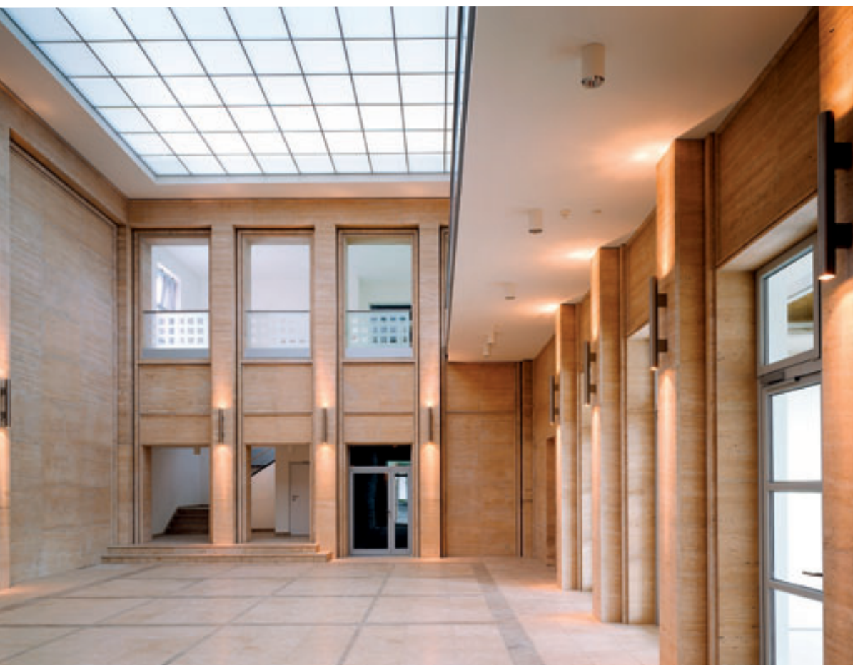
Glaslichtdecke mit eingelegten Glasscheiben im Eingangsbereich eines Industriegebäudes
