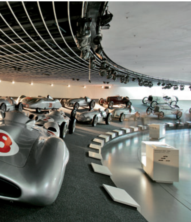
3D-geformte Aluminium-Rohrlamellendecke in einem Museum
