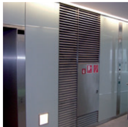
Detail: Technische Einbauten aus Edelstahl
