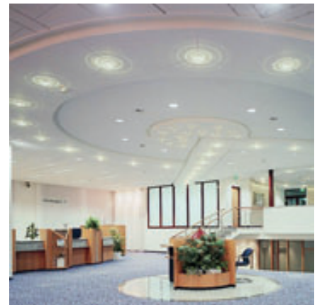
Kühldeckenverkleidung in einer Bank, mit integrierter Belüftung und Beleuchtung
