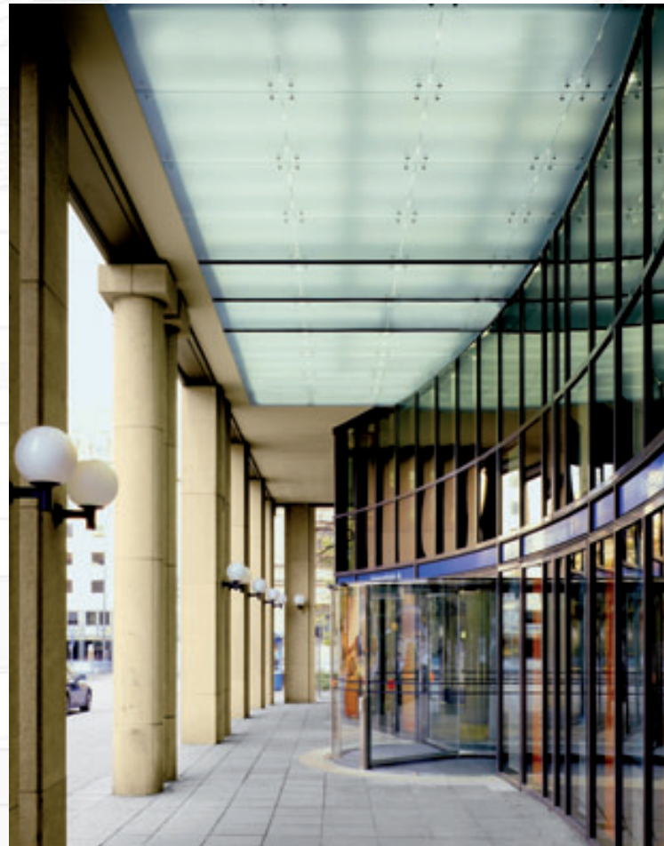
Glaslichtdecke mit Vierpunktbefestigungen im Außenbereich einer Bank
