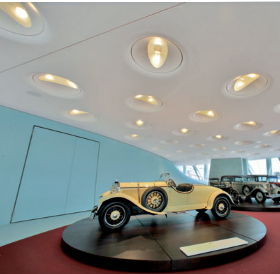
Kühldeckenverkleidung mit Lochgipsplatten und integrierten Sonderleuchten in einem Museum
