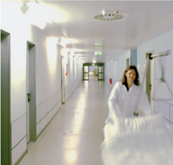
Abklappbare F30 Metall-Kassettendecke in einer Klinik
