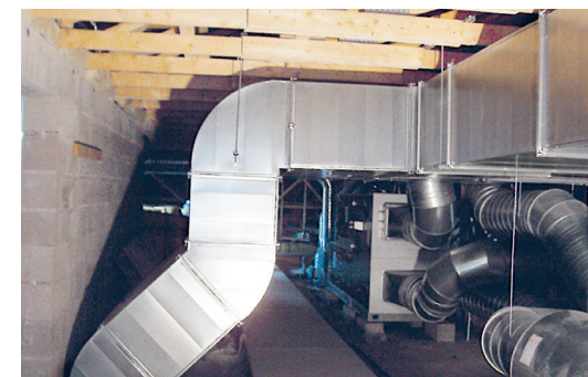
T-Abzweigung und passgenaue Führung von Rechteck-Kanälen
