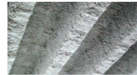
Ob Träger oder Beton – das Spritzsystem folgt gleichmäßig dem Profil des zu dämmenden Objekts
