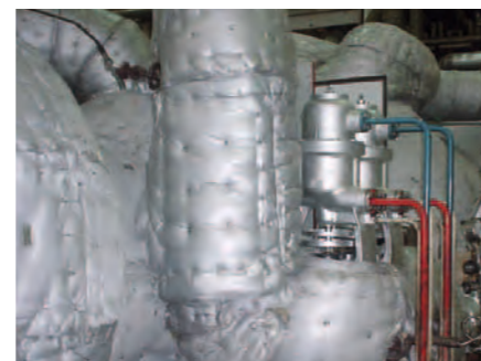
Komplette Turbinenisolierung mit Isoflex-Dämmkissen
