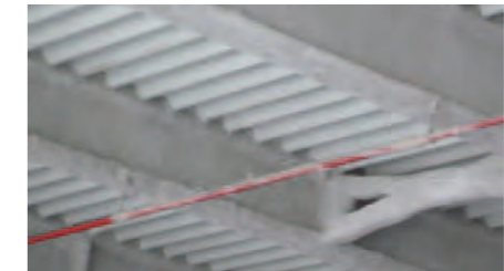
Freiliegende Konstruktionsteile werden von der Spritzmasse ummantelt
