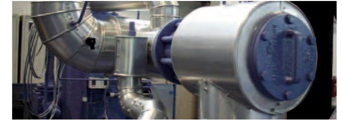
Mit PUR-Ortschaum und Alublech gedämmter Kühlwassersatz
