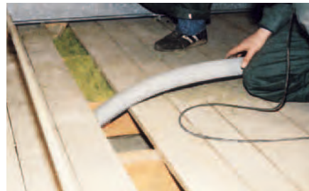
Einfach zu realisieren: Eine Holzbalkendecke erhält eine Einblasdämmung
