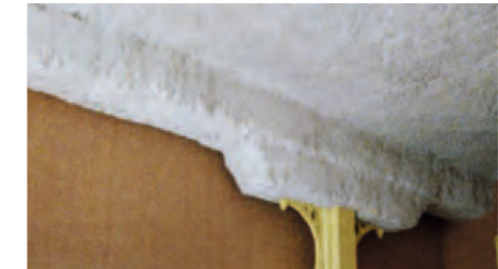
Spritzdämmsysteme haften an allen festen Oberflächen, in diesem Fall Holzbalkendecke und Holzträger
