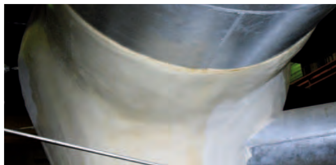
Detailansicht einer Spritzisolierung eines Schnellverschlussventils
